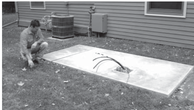
Figure 1.2 — Position Conduit
